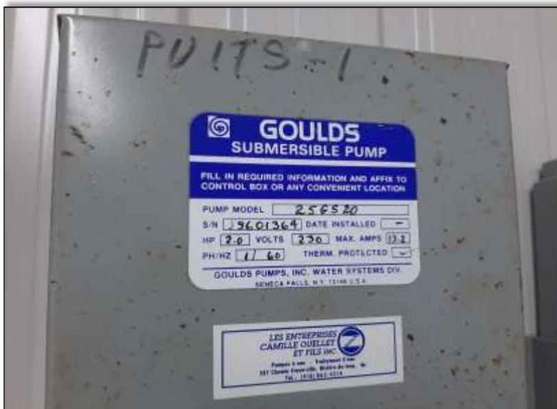
PHOTO #5: Modèle de pompe pour le puits Pelletier (puits secondaire datant des années 60) 2 HP
